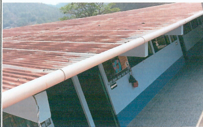
Foto 3: Cubierta delantera, parte externa.
