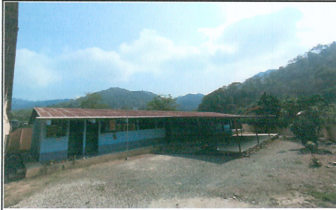
Foto 1: Vista panorámica del techo a sustituir.
